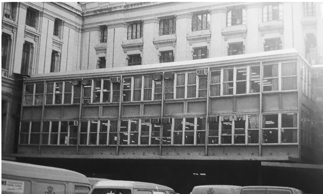
Edificio de Carteña, hoy desaparecido, en el muelle de Carruajes del Palacio de Cibeles, De la Sota 1963
